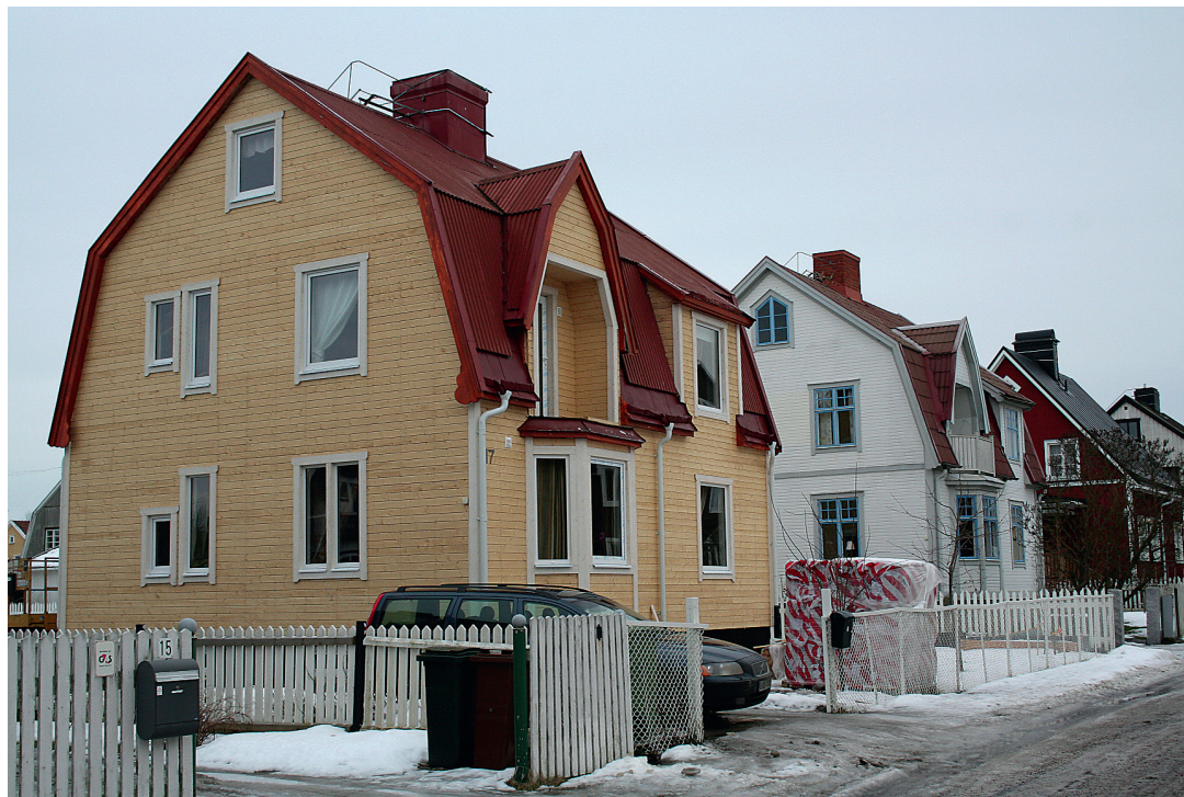
FIGUR 3. Två hus byggda 1925–35 i Brynäs, Gävle. På det närmaste huset framgår att fönstren bytts och en ny träfasad har satts upp efter tilläggsisolering. Även det andra huset har tilläggsisolerade väggar. FOTO: Gustaf Leijonhufvud 2017.
