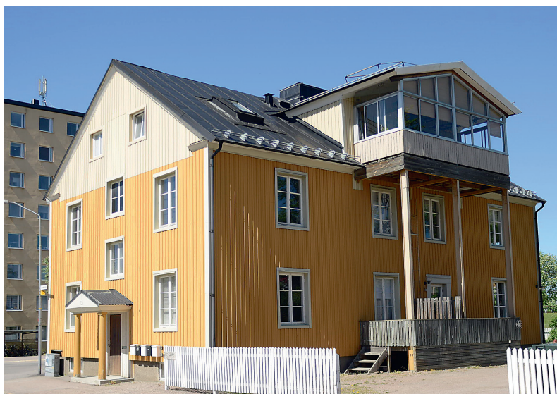
FIGUR 5. Tilläggsisolerat och kraftigt ombyggt hus i kvarteret Spettet, Brynäs i Gävle. Huset är ursprungligen byggt på 1920-talet. FOTO: Gustaf Leijonhufvud 2017.
