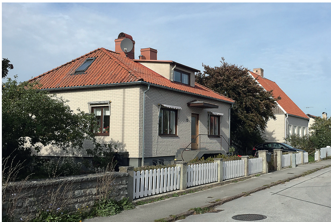
FIGUR 2. Vy över del av Polhemsgatan i Visby, exempel på villabebyggelse tilläggsisolerad med mexitegel. FOTO: Mattias Legnér.
