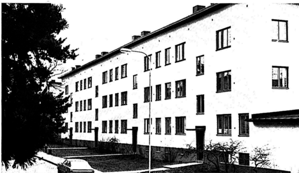
De flesta smalhusen har ljusa slätputsade fasader. Fönstren lades i fasadlivet och bildar tillsammans med putsen en slät yta utan nischer.
