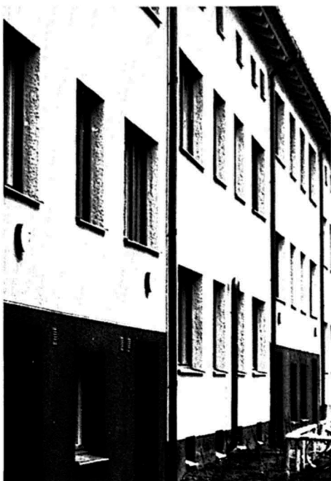
Fasadisolering med puts där fönstren ligger kvar i nischer. Fasaden blir en muryta med hål i, men mycket av ursprungskaraktären finns kvar genom material- och färgverkan.
