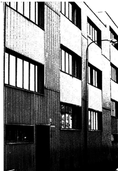
Fasadisolering med plåt. Genom materialverkan, skarvar, färgindelning och onödiga skador är husets ursprungskaraktär helt förvanskad.
