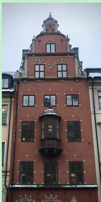
Hans Marschalcks hus på Hornsgatan 4 i Stockholm. Huset som är byggt år 1640 men fasaden genomgick omfattande renovering i början av 1900- talet. Fönsterna med deras småspröjs i bly och korspost speglar dock alljämt 1600-talets fönsterstil.
