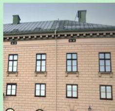
Sent 1700-tal. Bilden visar Tullhuset i Stockholm. Byggnaden är uppförd i slutet av 1700-talet fönsternas tvärpost ligger högt upp och fönsterbågarna med dess större glasformat och färre spröjsar är tidsypiska.
