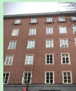
1920-tals byggnad på Swedenborgsgatan 5 a i Stockholm. Fönsterna under 1920-talet är influerade av antikens ideal såsom den tolkats under 1800-talet och återigen är det spröjsade, sexrutade fönstret utan tvärpost populärt.
