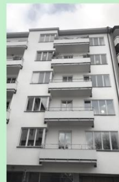
1930-tals byggnad på Bellmansgatan 26 i Stockholm. Byggnad uppförd år 1937. Funktionalismens ideal och rena former innebär att glasformatet får styra och spröjsarna försvinner.
