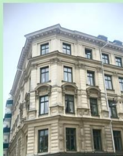
Nybrogatan 42 i Stockholm. Byggnad från år 1882. Fönsterna är typiska för 1800-talets senare där den ökade byggnadstakten och hälsovårdstankar leder till att takhöjden blir högre. Detta i kombination med att det går att tillverka större glasformat leder till att spröjsen försvinner samtidigt som tvärposten kommer tillbaka.
