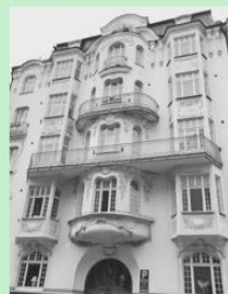
Början av 1900-talet. Byggnad uppförd år 1905 på Fredrikshosvagnsgatan 5 i Stockholm. Byggnadens fönster går i jugendstilens ideal och är försedda med spröjs. Denna gång har dock spröjsen ingen konstruktiv funktion utan motiveras istället av rent arkitektoniska och estetiska skäl.
