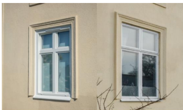
Ett nytt aluminiumfönster till vänster och ett gammalt i trä till höger på en fastighet i Nyköping. Foto: David Hansson, Sörmlands museum.
