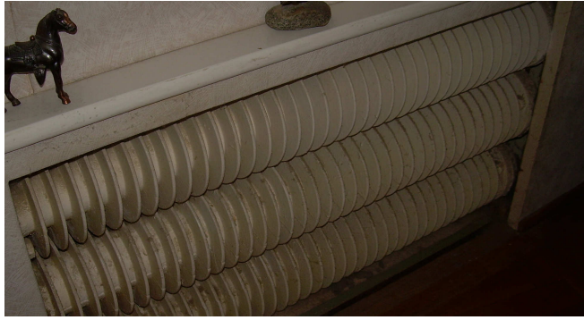
Bild 7. Äldre installationsteknik har också ett kulturhistoriskt värde
