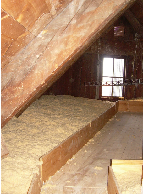
Bild 5. Isolering av vindsbjälklag
