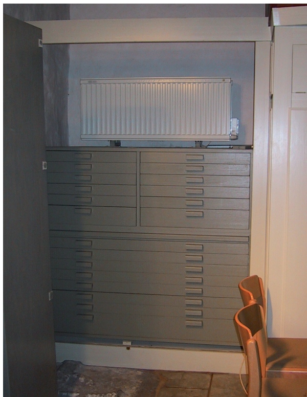
Figur 1. Tidigare textilskåp i Väskinde kyrka. Observera placeringen av värmeelementet.
