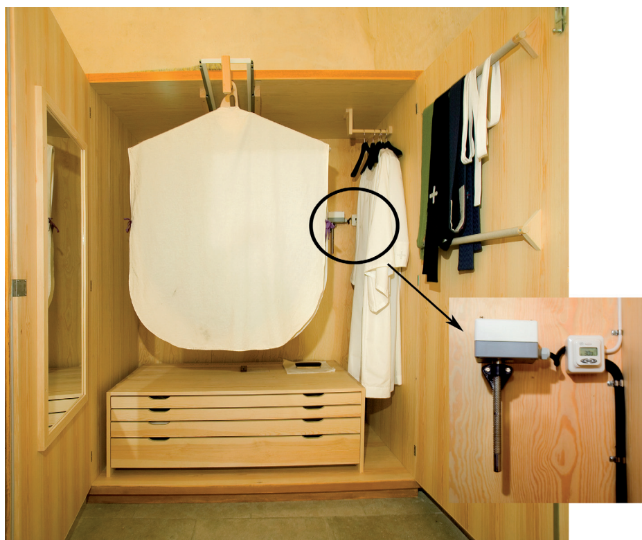
Figur 4. Textilskåpen har en värmefolie i botten vilken styrs av en hygrostat (inringad).
