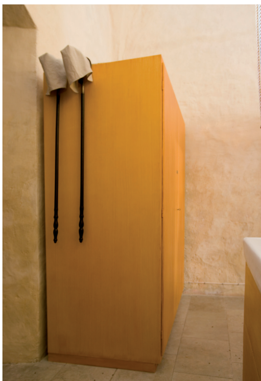
Figur 7. Utifrån ser klimatskåpet i Linde ut som ett vanligt skåp men inuti finns hygroskop och värmefolie för att styra innerklimatet så att textilierna förvaras optimalt. Kollektståvarna hänger utanpå skåpet på kuddar och skyddas mot fukt av hättor av linne.
