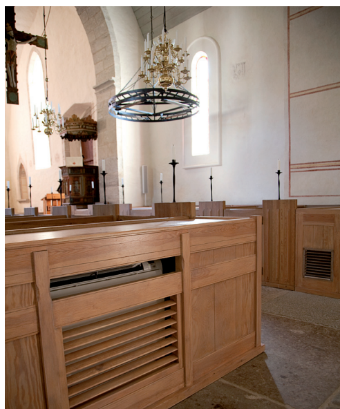
Figur 3: Inbyggd värmepump i Garda kyrka på Gotland.
