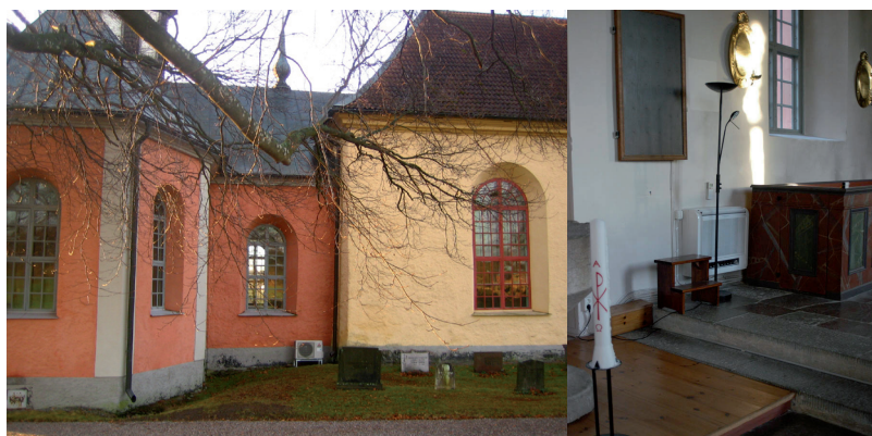
Figur 7. Värmepumpens placering ut- och invändigt.
