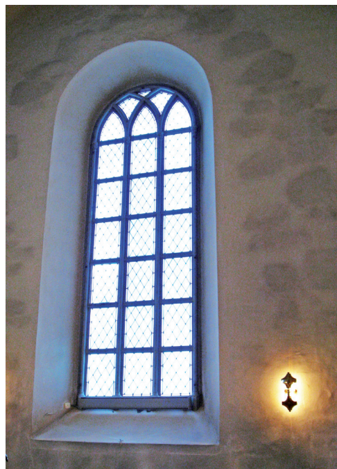
Figur 11. Köldbryggor i muren orsakar fläckvis försmutsning.
