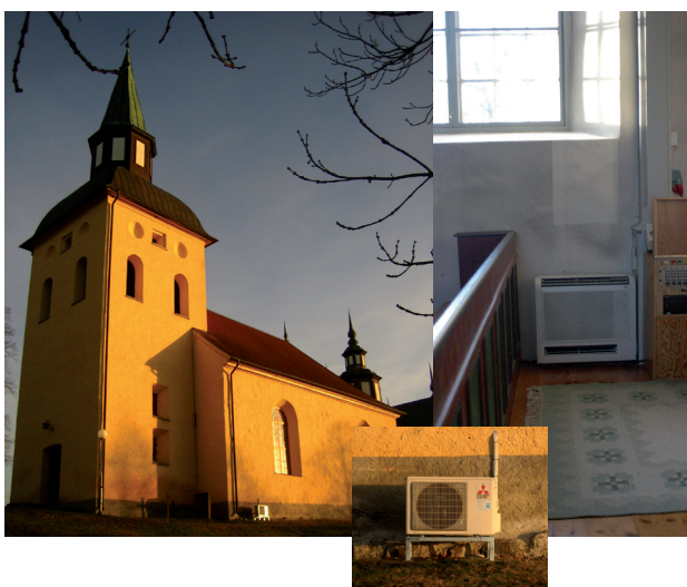
Figur 6. Värmepumpens placering ut- och invändigt.
