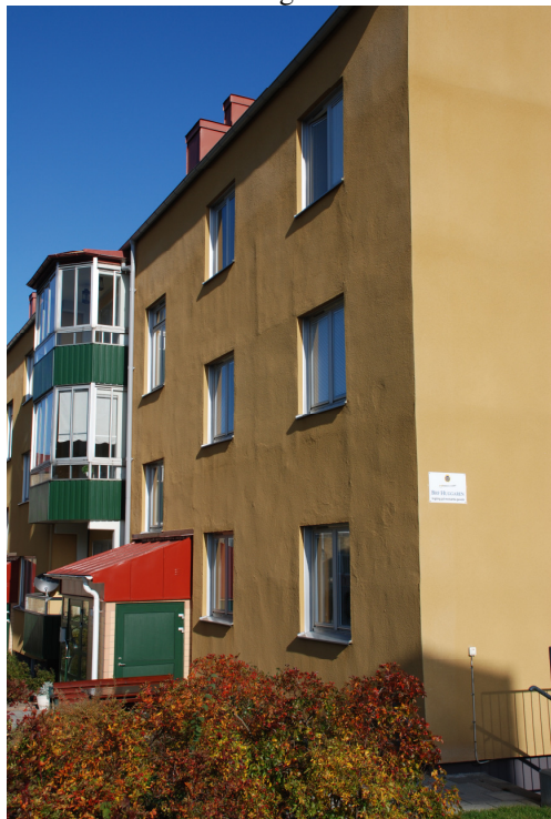
Figur 8.8 Brf Huggaren (Malmö) efter tilläggsisolering av fasad.
