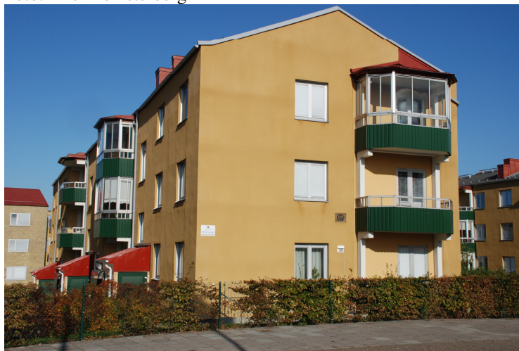
Figur 8.7 Brf Huggaren (Malmö) efter tilläggsisolering av fasad.
