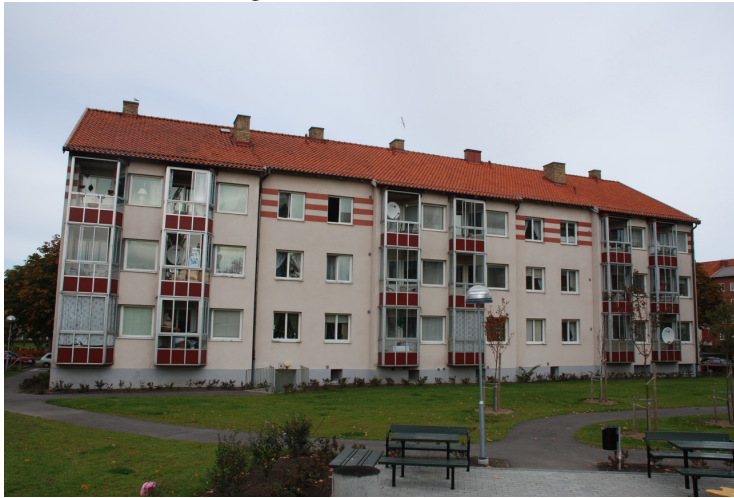
Figur 8.12 Fastigheten Hösten (Malmö) efter tilläggsisolering av fasad.
