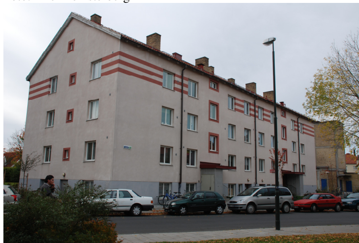
Figur 8.17 Taksprång, fastigheten Hösten (Malmö) efter tilläggsisolering av fasad.
