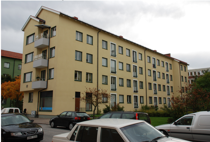
Figur 8.1 Brf Ryttmästaren (Malmö) efter tilläggsisolering av fasad.
