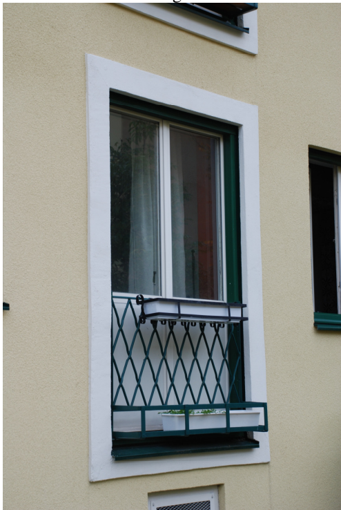
Figur 8.2 Fönsterdörr, Brf Ryttmästaren (Malmö) efter tilläggsisolering av fasad.
