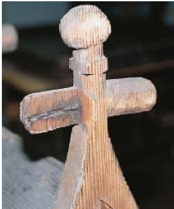
Hög relativ fuktighet har gjort att spiken har rostat och spräckt träet.
