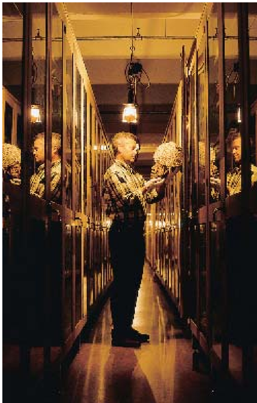
Belysningen i magasinen består av flyttbara, balansupphängda sladdlampor som tänds individuellt.
