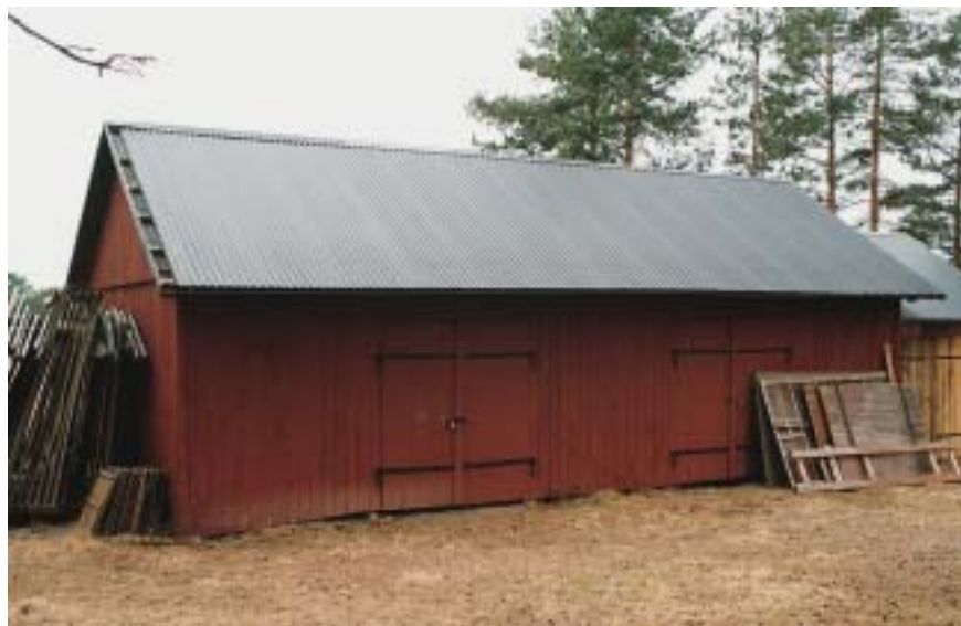
Vagnsskjulet. Planklador med regelverksstomme är olämpliga som museibygnader på grund av kraftiga svängningar mellan torr och fuktig inomhusluft. Detta gäller i synnerhet lador försedda med plåttak.
