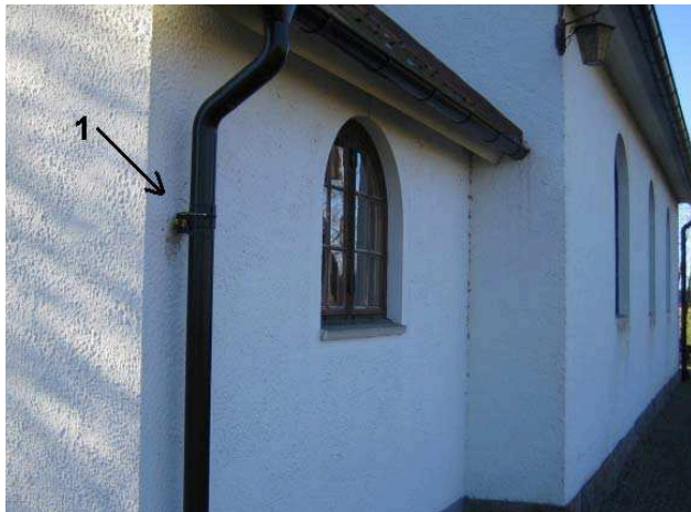
Bild 1A3: Loggning ute vid nordöstra gaveln.
