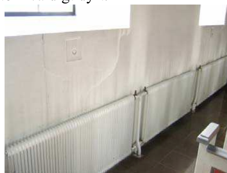
Bild 2: Svärtning på väggarna över radiatorerna i Laholms kyrka
