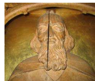
Bild 1: Uttorkningsskada eller sprickbildning på grund av för stora variationer av RF.
