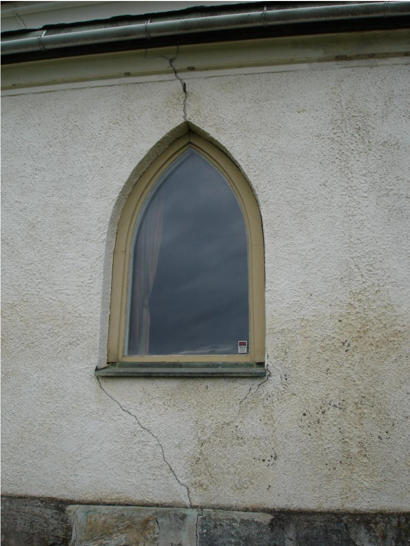
Foto 15. Typiske tegn på setningsskader er skrå-sprekker over og/eller under vindusåpninger. Foto: NIKU
