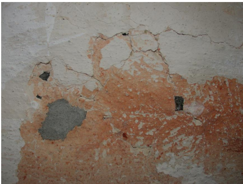
Foto 17. Bønsnes kirke. Skader i form av krakkeleringer i innvendige puss- og kalkmalingslag. Foto:NIKU
