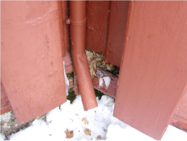
Foto 23. Selv små tiltak, som å kaste vannet lenger ut fra bygningskroppen, kan gi meget stor effekt og på sikt hindre utvikling av store skader. Her har vann fra nedløpet blitt kastet inn mot bygningskroppen og gitt omfattende råteskader. Foto: NIKU
