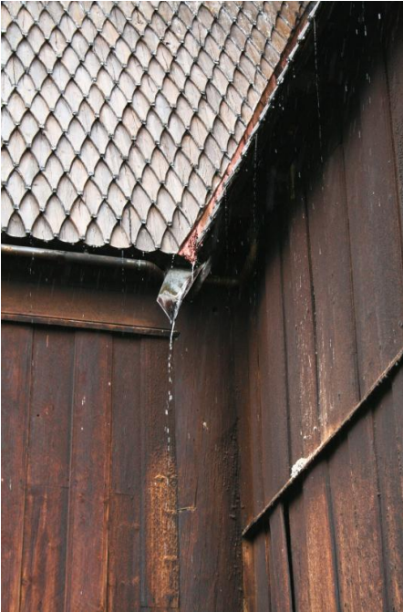
Foto 4. Ringebu stavkirke i øsende regn. Kirken har ikke nedløpsrør, hvilket medfører økt belastning på treverket. Foto: NIKU
