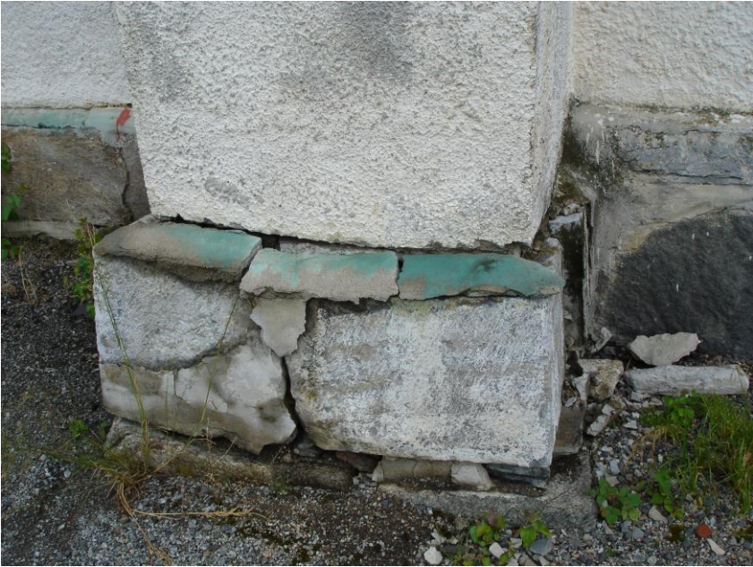
Foto 1. Feilaktig materialbruk, som sementholdig mørtel i eldre murkonstruksjoner, i kombinasjon med frost på fuktutsatte steder kan gi store skader. Foto: NIKU
