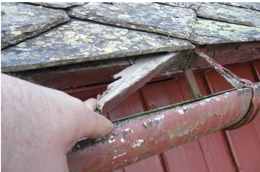
Foto 14. Snøinndriv i raftet kan føre til råteskader på takkonstruksjonene. Foto: NIKU
