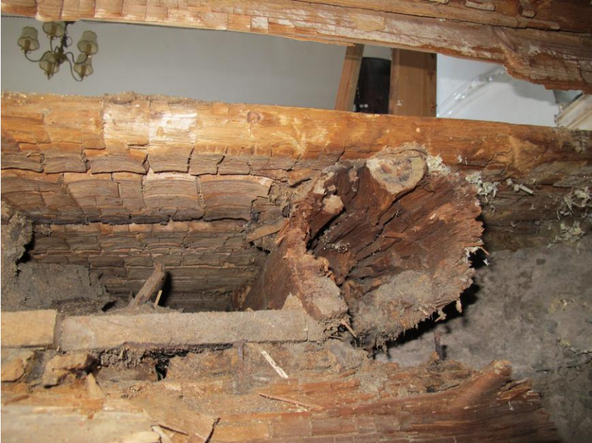
Foto 22. Råteskadet treverk, Gersgården, Ljusnäs. Foto: Mycoteam
