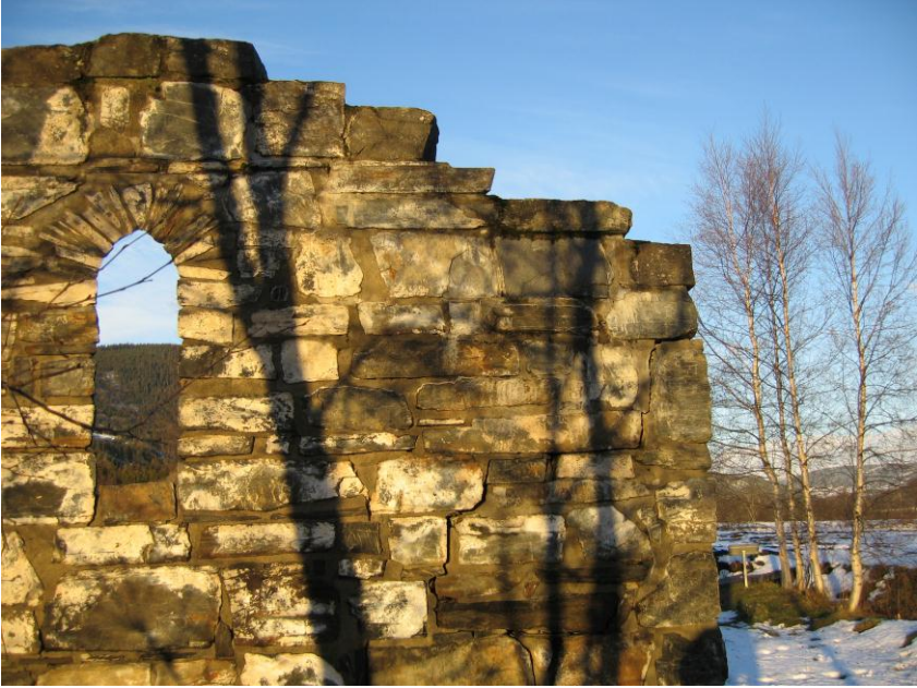
Foto 13. Mo kirkeruin. Frost i murverk har sprengt og utvidet sprekker. Foto: NIKU
