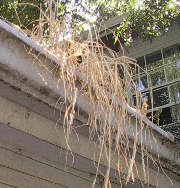
Foto 20. Eksempel på vegetasjon forhindrer avrenning og fungerer som fuktreservoar, en gjengrodd takrenne. Foto: Ted Garvin
