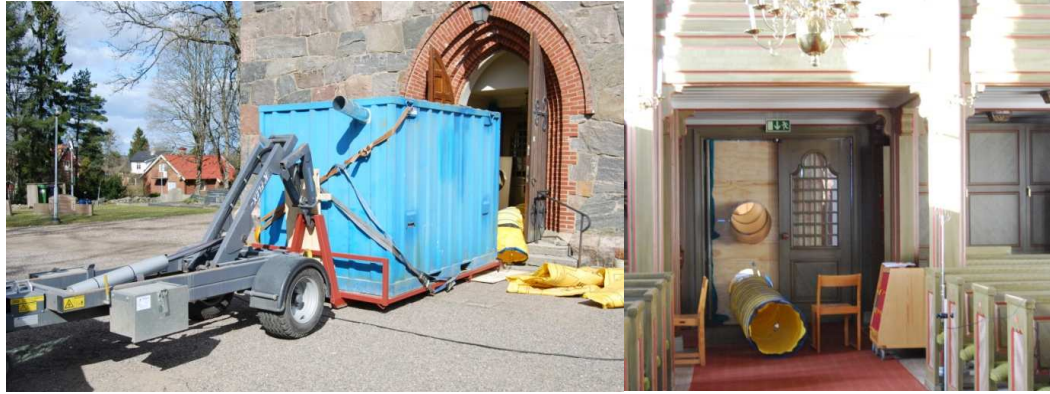
Bild1 och 2: Containern i vilken värmepannan är placerad och installationen av rören i kyrkans port.
