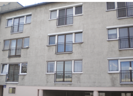
Fallstudiebyggnaden sedd från gatan
