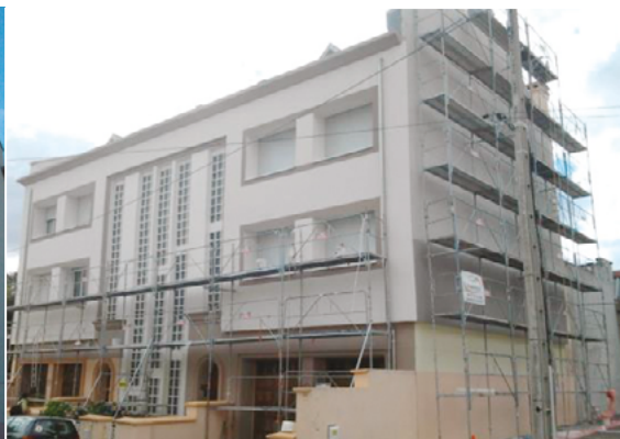
Byggnaden under arbetet
