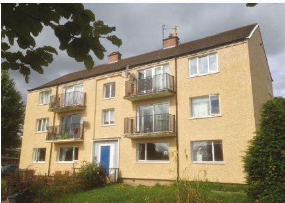
Den färdigställda väggisoleringen
