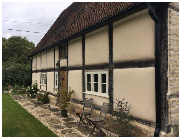
Figur 19-21. Efter att en listad engelsk kulturbyggnad skadats av brand återuppbyggdes det med hampakalk som putsbärande skikt såväl i korsvirkessommen som i invändiga tak. Foto: Kristin Balksten
