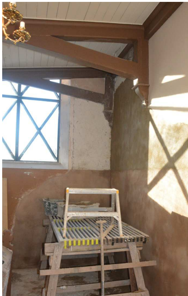
Figur 22-23. Den färdiga putsytan är här utförd med infärgat kalkbruk av NHL3,5 1:1,5 0-4 mm, med en närliggande kulör som färdig avfärgad yta. Foto: Kristin Balksten
