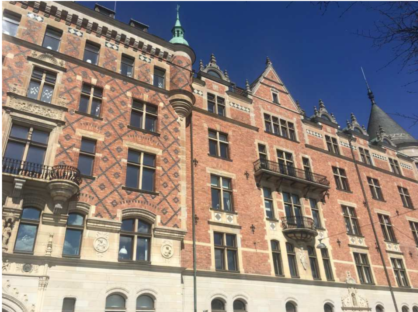
Figur 6. Strandvägen 29-33, en nationalromantisk borg murad i kryssförband. Foto: Frida Johansson
