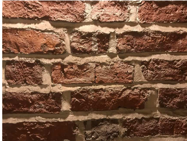
Figur 1. Medeltida tegelmurverk, Mariakyrkan i Sigtuna. Här syns teglets ojämna bränningsgrad, den feta stålade kalkfogen och murverkets homogenitet med god vidhäftning mellan bruk och tegelsten.
