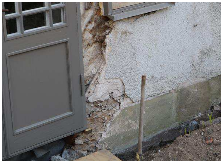
Figur 24. Norra gaveln på S:ta Gertrud 8. Under den nyinstallerade dörren har det tidigare varit en tjock betongplatta som trappsteg. Bakom den var syllan helt uppruttnad, men bredvid har syllan klarat sig. Foto: Sofie Nygren
