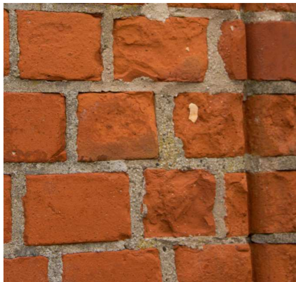
Figur 40. Frostsakat tegel där dels bara yttre täta skalet frusit av och dels där djupare frostsador gett tydligare materialförlust.
