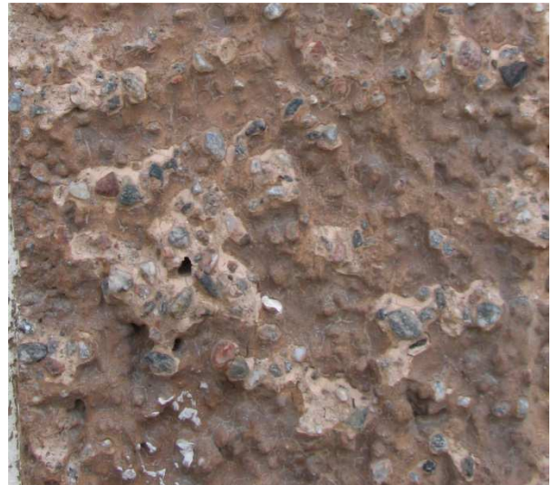
Figur 19. Närbild på en infärgad kalkcementputs där ytskiktet har förgipsats. Det innebär att ytan upplevs som mycket smutsig och benägen att skikta sig. Under ytskiktet syns originalkulören.
