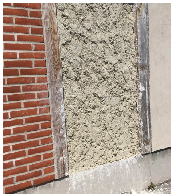
Figur 28. Utvändig tilläggsisolering av hampakalk under uppbyggnad. Till vänster; tegelvägg med invändig hampakalk.
