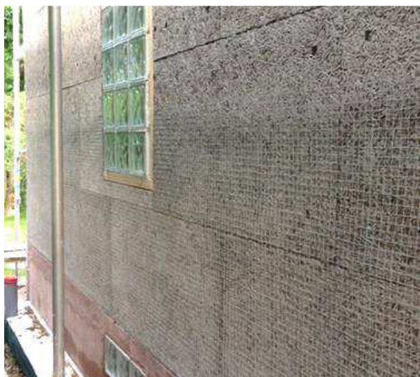
Figur 16. Trällitplattor som putsbärare på nyuppfört trähus 2016. Foto: Kristin Balksten
