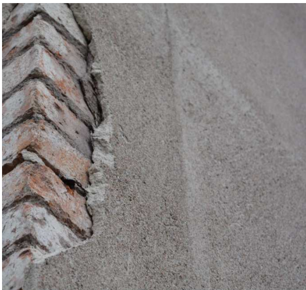
Figur 32. Yttersta skiktet på porös kalkputs från 1970-talet har ombildats genom viss omkristallisation.
