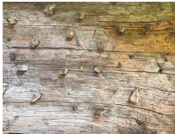
Figur 8. Små träpliggar omkring 5 cm långa slås in i väggarna, för att putsen ska ha något att fastna på. Pligging är en bättre metod än råhuggning när ett kalkbruk används. Foto: Kristin Balksten
