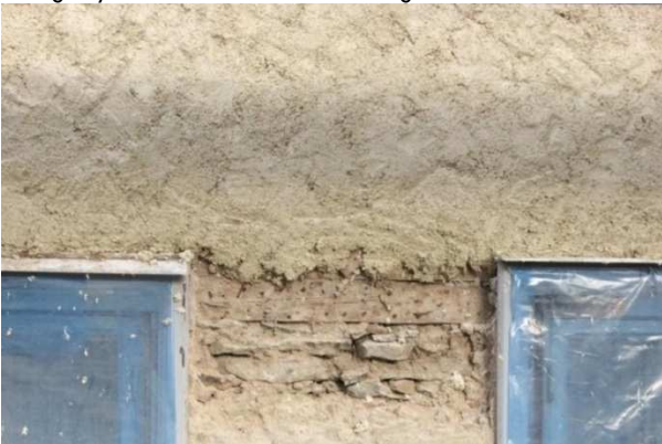
Figur 10. När hampakalken har härdat utgör den ett mycket bra underlag för kalkputs. Här går den i liv med den gamla kalkstensstommen. Foto: Anna Donarelli
