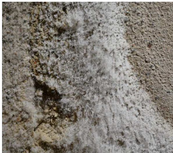
Figur 14. Här syns natriumsulfatets trädliknande kristallbildning, vilken är vanlig just i nybildade kristaller.
