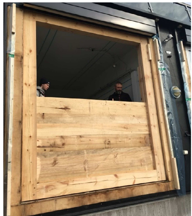
Figur 15. Bulhusvägg under uppbyggnad av HN Byggnadsvård och Kristoffer Fredriksen. Foto: Paulien Strandberg
