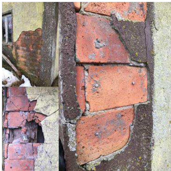
Figur 15. Reveteringstegel på ett trähus på södra Öland. Foto: Kristin Balksten
