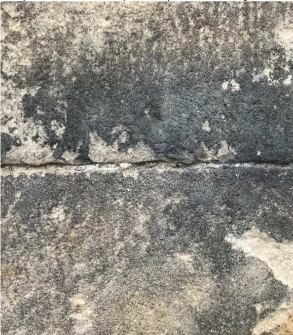
Figur 18. Gipskrusta (black crust) syns oftast genom att svavel har reagerat med kalken i ytan på kalcitbunden sten eller kalkbruk
