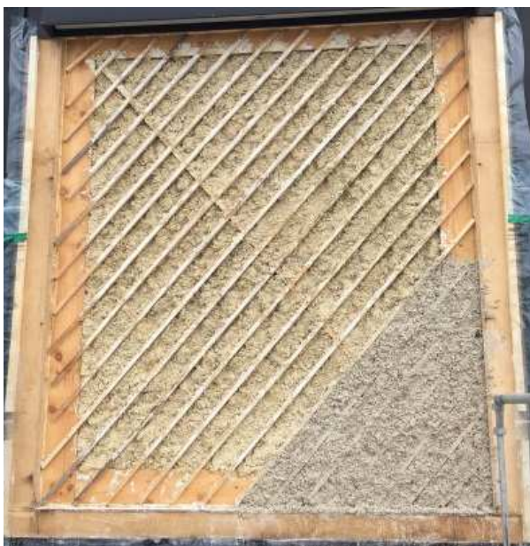
Figur 17. Bulhusvägg som putsas med hampakalk, i två påslag. Foto: Paulien Strandberg
