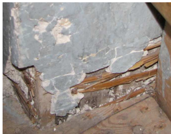
Figur 11. Rörning av trävägg bevarad under Drottningholms teaterns originalputs från 1760-talet. Foto: Kristin Balksten
