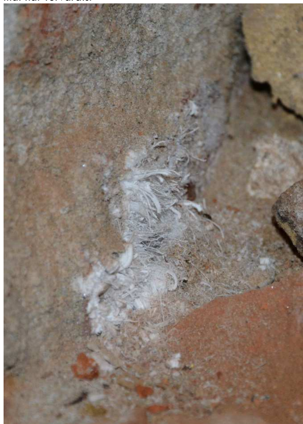
Figur 25-26. Halitkristaller på tegelvägg. Här syns tydligt hur de växer till från en yta och bildar dels kompakta kristaller och dels långa trådar. Båda exemplen är ifrån källare där mat har förvarats.
