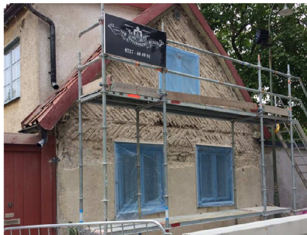
Figur 6. Gavelspetsen med sina diagonala ribbor. Nertill är kalkstensmurverket och dess puts bevarade. Foto: Anna Donarelli
