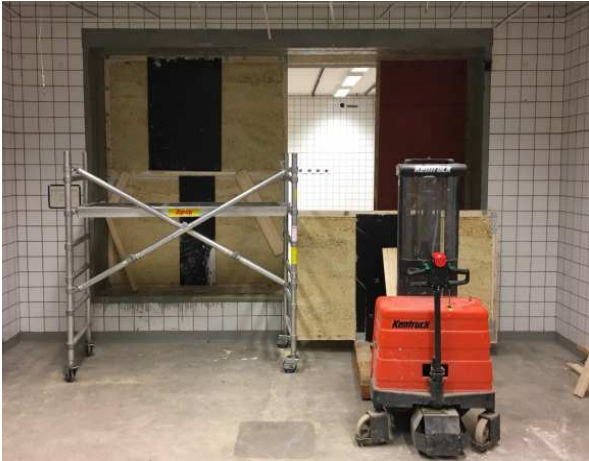
Figur 7: Bild på momentet när modulerna monteras på plats i luftljudslaboratorium på LTH. De fyra modulerna tätades med akrylfogmassa mellan varandra och till angränsade mellanrum i väggen för att minimera felaktiga mätvärden på grund av luftläkage mellan mottagar- och sändarrum.
