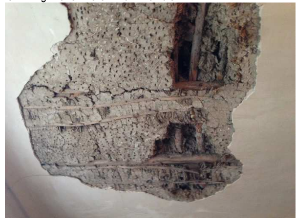
Figur 18: Lerklinat tak på Värmlands Säby, med grenar som binder fast leran, som i sin tur skyddar bjälklaget.
