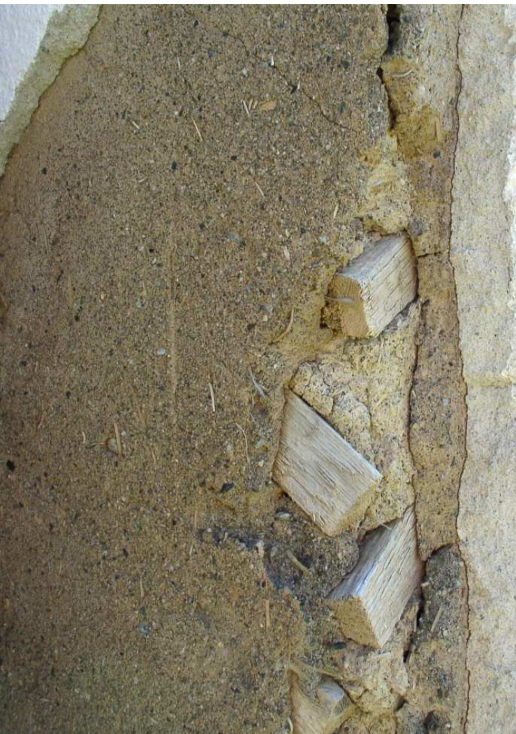
Figur 4. Lerbruk i grundningen förekommer på reveterat hus i Skyttmon i Jämtland. Notera även ribbornas form med smala sidan inåt. Foto: Kristin Balksten
