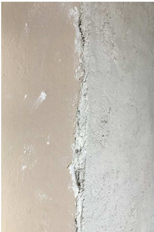
Figur 20. Genom att materialet är formbart kan det appliceras även i smyggar och i rundade valv, här i angränsning till gammal puts. Foto: Kristin Balksten
