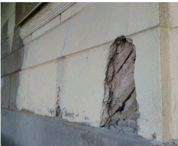
Figur 20. Lagning av kalkputs på ribbor. Lagningen utförs med KC-bruk utan fuktspärr. Risk för lokal framtida röttskada. Foto: Kristin Balksten
