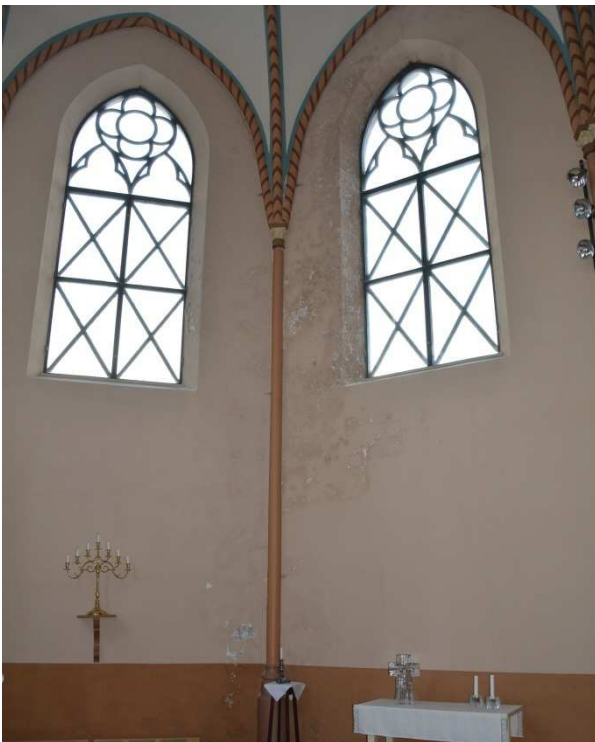
Figur 13. Väggfälten i koret som nu omputsats pga. återkommande saltskador. Foto: Kristin Balksten
