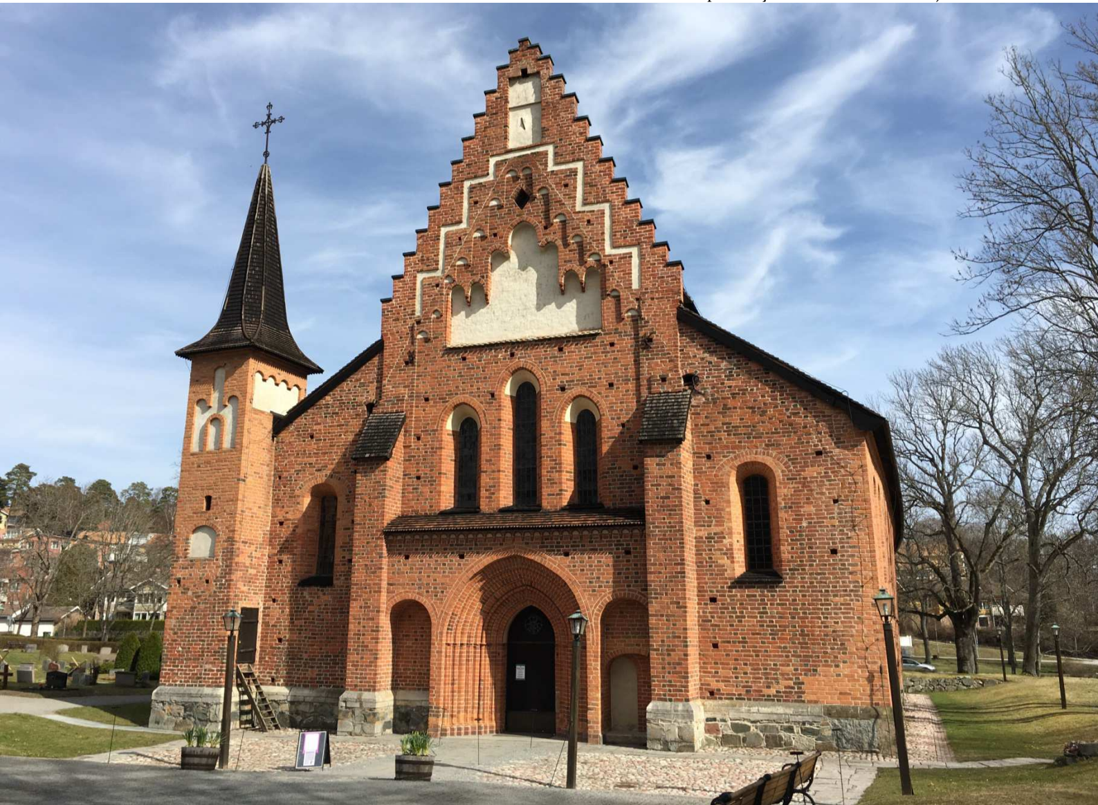
Figur 2. Mariakyrkan i Sigtuna, uppförd av dominikanermunkarna och invigd 1255. Teglet brändes i provisoriska ugnar strax norr om bygget, och murades i ett så kallad munkförband. Foto: Frida Johansson
