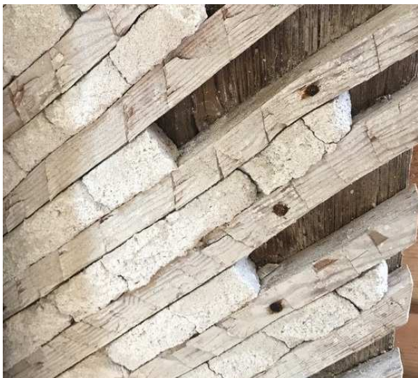
Figur 9. Tätt sittande råhuggna ribbor med puts emellan. Ribborna fästa vanligtvis diagonalt mot väggens plank eller timmer. Ofta är ribborna en aning koniska fästa med den bredare sidan utåt. Det ger mycket bra fäste för putsen. Ibland har mellanrummet också fyllts ut med exempelvis tegelskärvor. Foto: Kristin Balksten
