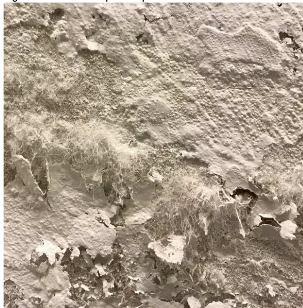
Figur 25-26. Halitkristaller på tegelvägg. Här syns tydligt hur de växer till från en yta och bildar dels kompakta kristaller och dels långa trådar. Båda exemplen är ifrån källare där mat har förvarats.
