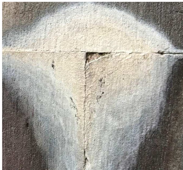
Figur 35-36. Kalk har frigjorts inuti ett murverk och avsatts som stalaktiter på ytan, här som floatstone på Lunds domkyrka och som stalaktiter på Visby ringmur.
