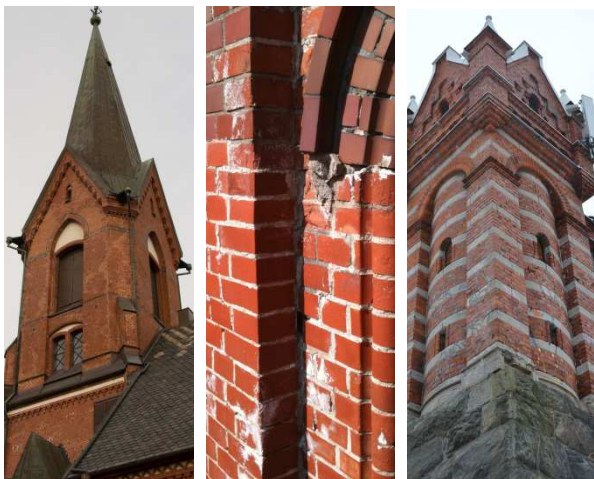
Figur 46. Skadorna är tydligt koncentrerade efter väderstreck.
