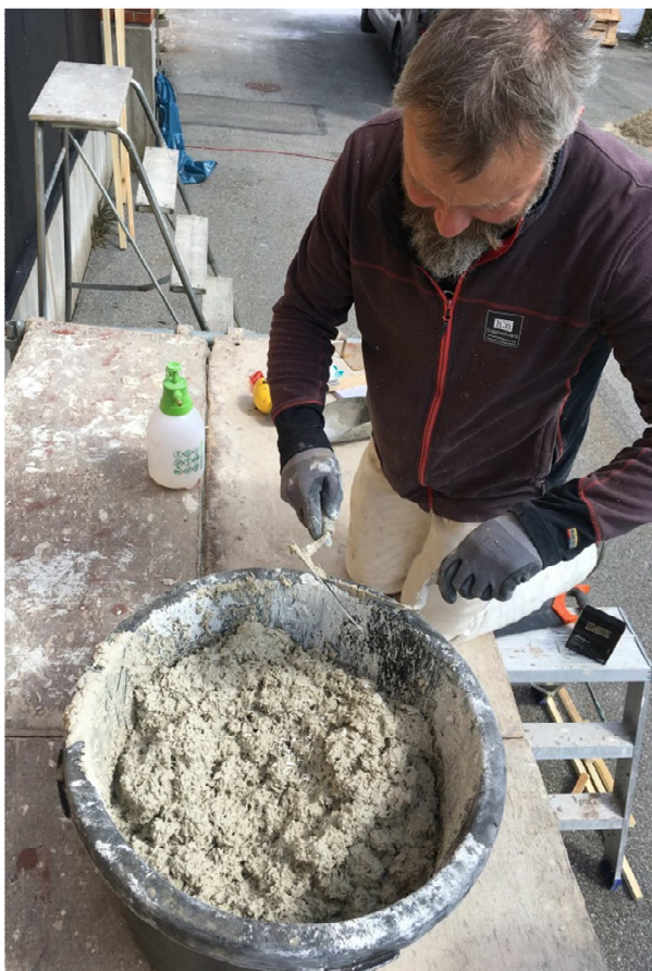
Figur 16. Konsistensen på hampakalk med blandningsförhållande 4 spann kalk/7 spann hampa/4,25 spann vatten kan anas i "rullen". Foto: Paulien Strandberg
