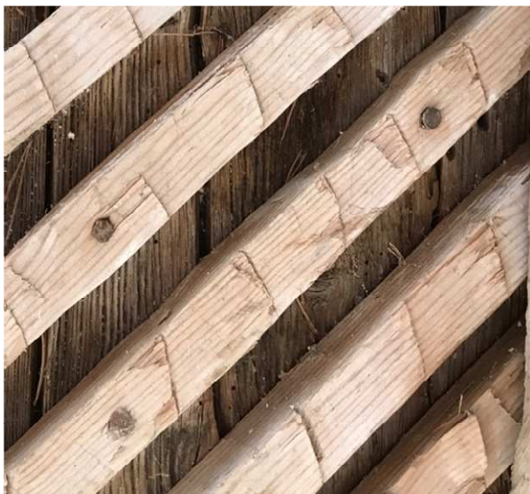
Figur 6. Genom att hugga med yxa i träet bildas små flisor/spån som bruket kan bita sig fast i. Tekniken har använts på timmerstommar och på skiftesverkshusens bulor och stolpar. Här syns råhuggning på ribbor. Foto: Kristin Balksten
