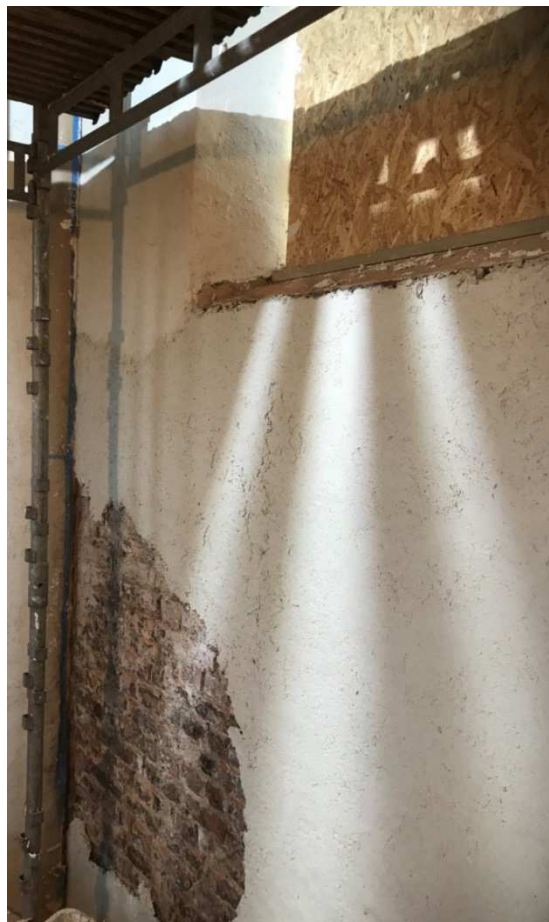
Figur 18. Hampakalk som utstockning på tegelvägg. Foto: Kristin Balksten
