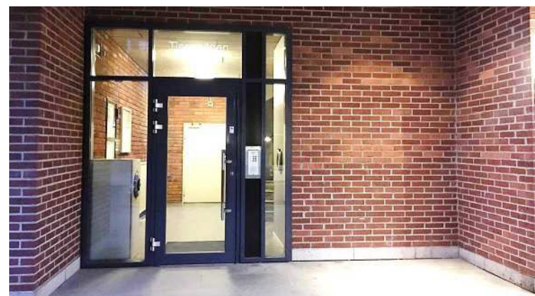
Figur 9. Tegel som skalmur i ett miljonprogramshus i Sollentuna. Modernt löpförband. Foto: Frida Johansson
