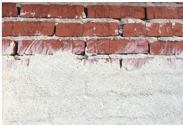
Figur 6. Kalkputs under applicering på en tegelvägg. Foto: Paulien Strandberg
