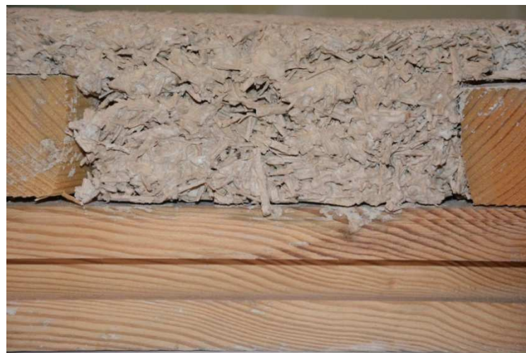
Figur 9. Hampakalk av torrsläckt Ölandskalk och hampaskävor, som bärs av diagonala ribbor på plankstomme. Foto: Kristin Balksten
