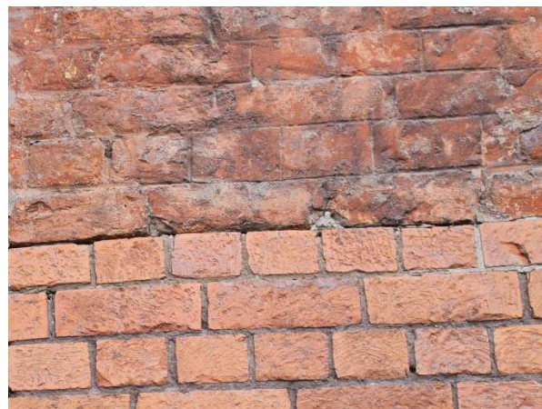
Figur 5. 1500-talstegel och 1700-talstegel i S:ta Clara kyrka. Notera de olika förbanden. Foto: Frida Johansson
