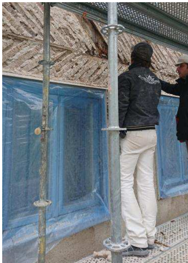
Figur 7. Tom och Pär dokumenterar väggen med dess konstruktion, material och gamla skador. Foto: Anna Donarelli
