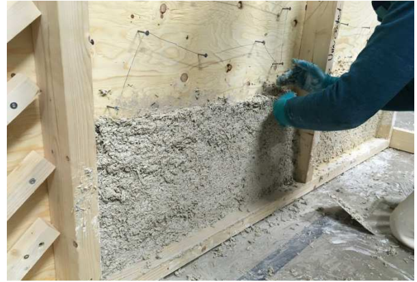
Figur 25. exempel på hur hampakalken kan fästas till underliggande konstruktion, med hjälp av befintliga ribbor eller med glesstätt ståltråd. Putsnät är i regel för tät för att det skall vara lätt att få in hampakalken bakom. Foto: Paulien Strandberg
