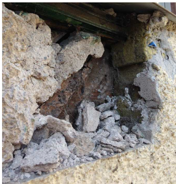
Figur 1. Tilläggsisolering med mineralull på bulhusstomme, Östermur 28 i Visby. Foto: Anna Donarelli
