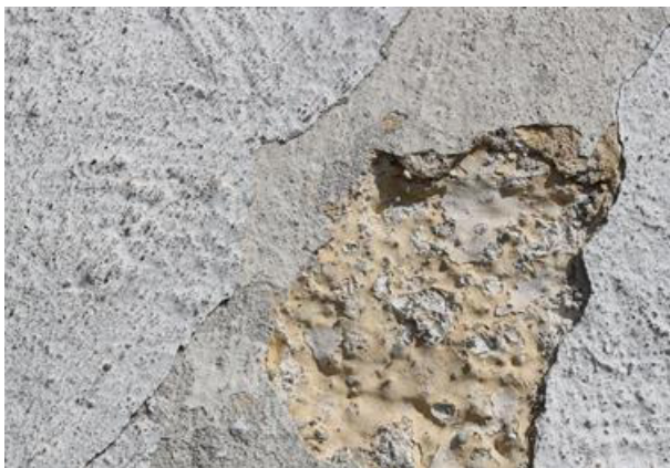
Figur 21. Klinten 8. Den cementhaltiga slamningen sitter inte lika hårt fast i underlaget som på bilden t.h. Cementslamman är inte heller lika hård. Foto: Sofie Nygren
