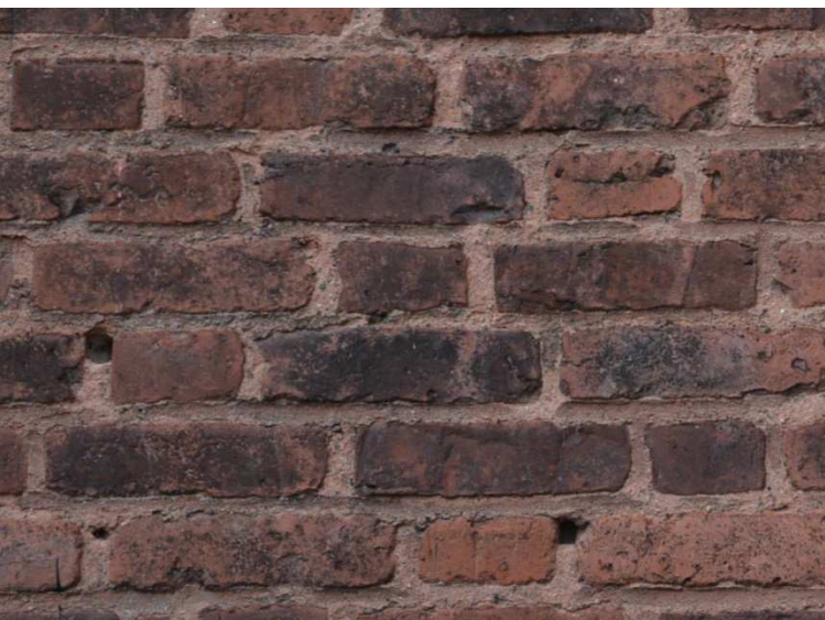
Figur 7. Dragen originalfog på Göteborgs Naturhistoriska museum från 1919. Här syns det 2 cm tjocka pigmenterade fogbruket som ligger utanpå ett ljus porösare kalkmurbruk.
