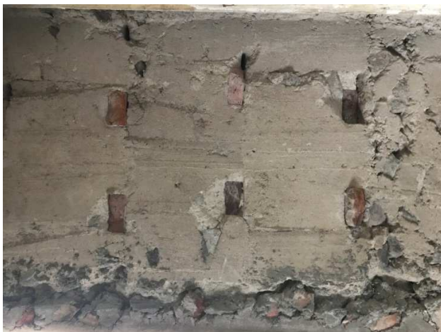
Figur 12. I gjuthuset Stora Sörgården i Utby syns ännu brändornas avtryck i väggarna. Foto: Kristin Balksten
