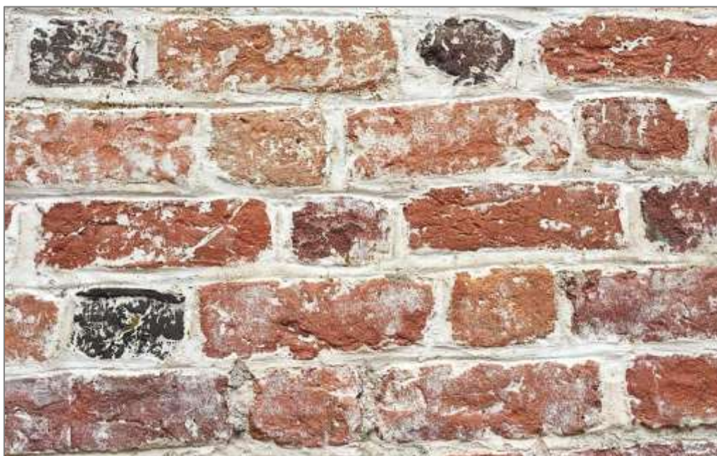
Fig. 4. Tegel på Gripsholms inre borggård. Vendiskt förband. Teglet har varit belagt med puts. Murverk från 1500-tal - men teglet kan vara så gammalt som 1200-tal. Foto av Frida Johansson.
