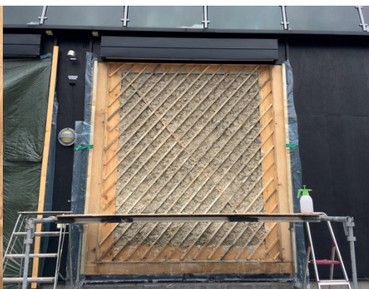
Figur 6. En bulhusvägg med hampakalk tilläggsisolering under uppbyggnad på Energi- och Byggnadsdesign laboratorium, Lunds Tekniska Högskola.
