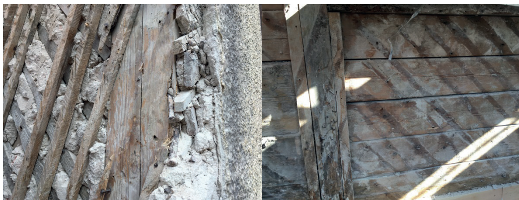
Figur 1. En reveterad bulhusvägg i Visby som renoveras. Till vänster reveteringen med träribbor, till höger syns ytputsen.
