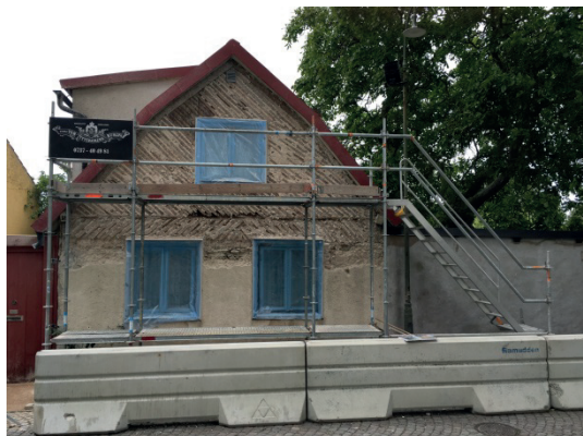
Figur 7. Renovering av en gavelvägg i Visby pågår, september 2017. Ytputsen har avlägsnats och träribborna är synliga.
